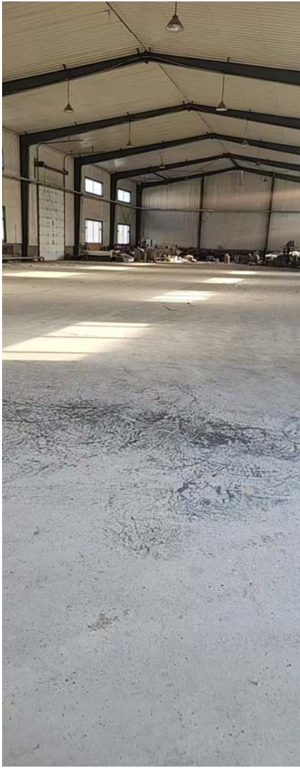
厂房内地面硬化照片
