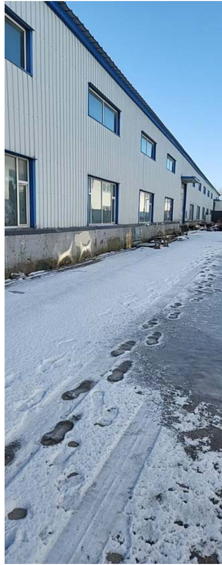
厂房外地面硬化照片
