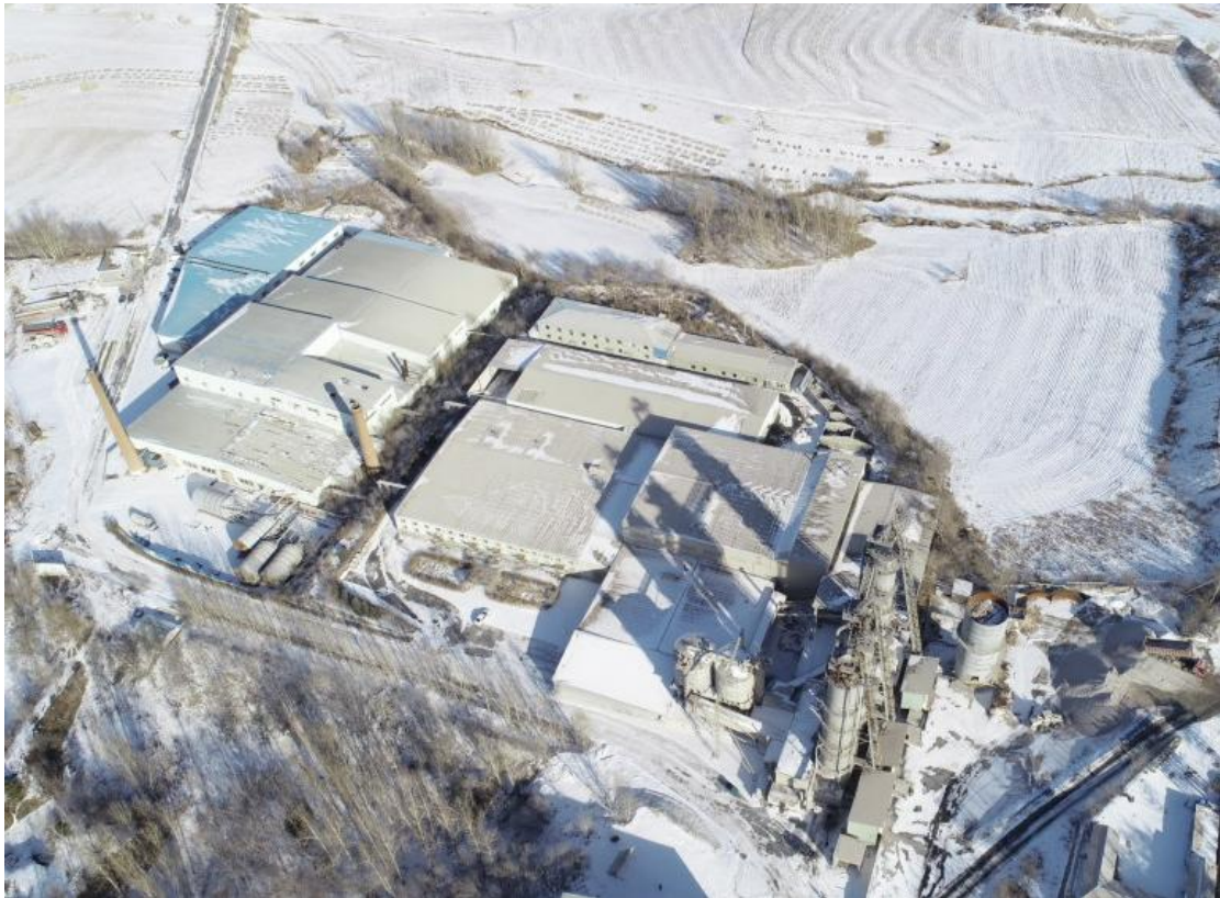
照片 1-2 相邻建筑—天成高新纳米复合材料有限公司 工业厂区现状照片（拍摄镜向 北东 70° ）
