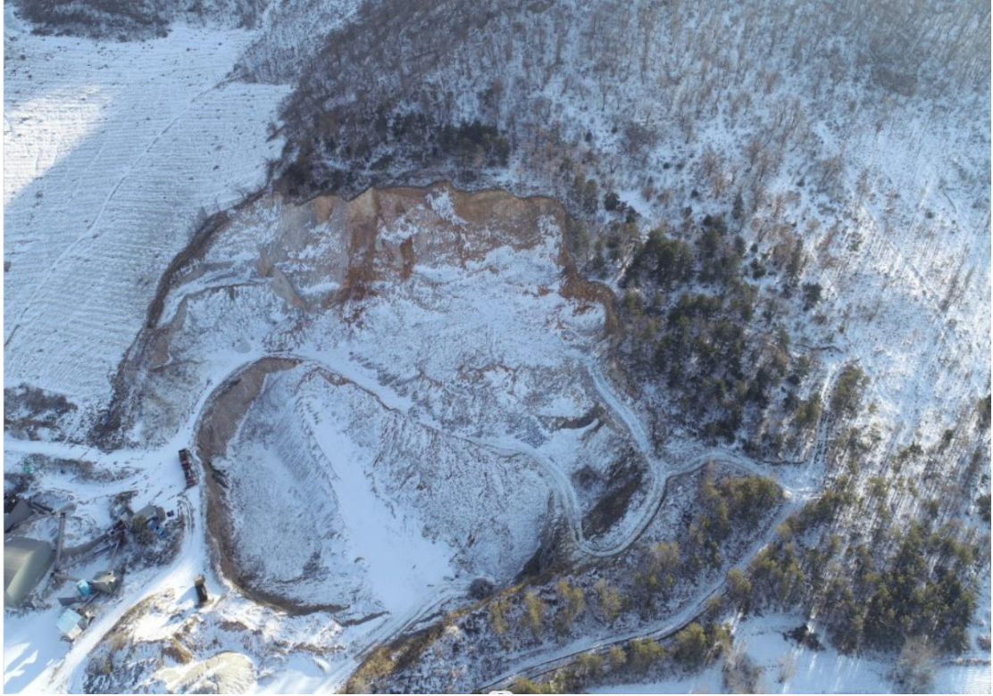
现场照片 1-4 露天采场（拍摄日期 2024 年 2 月 27 日，小河子村境内）
