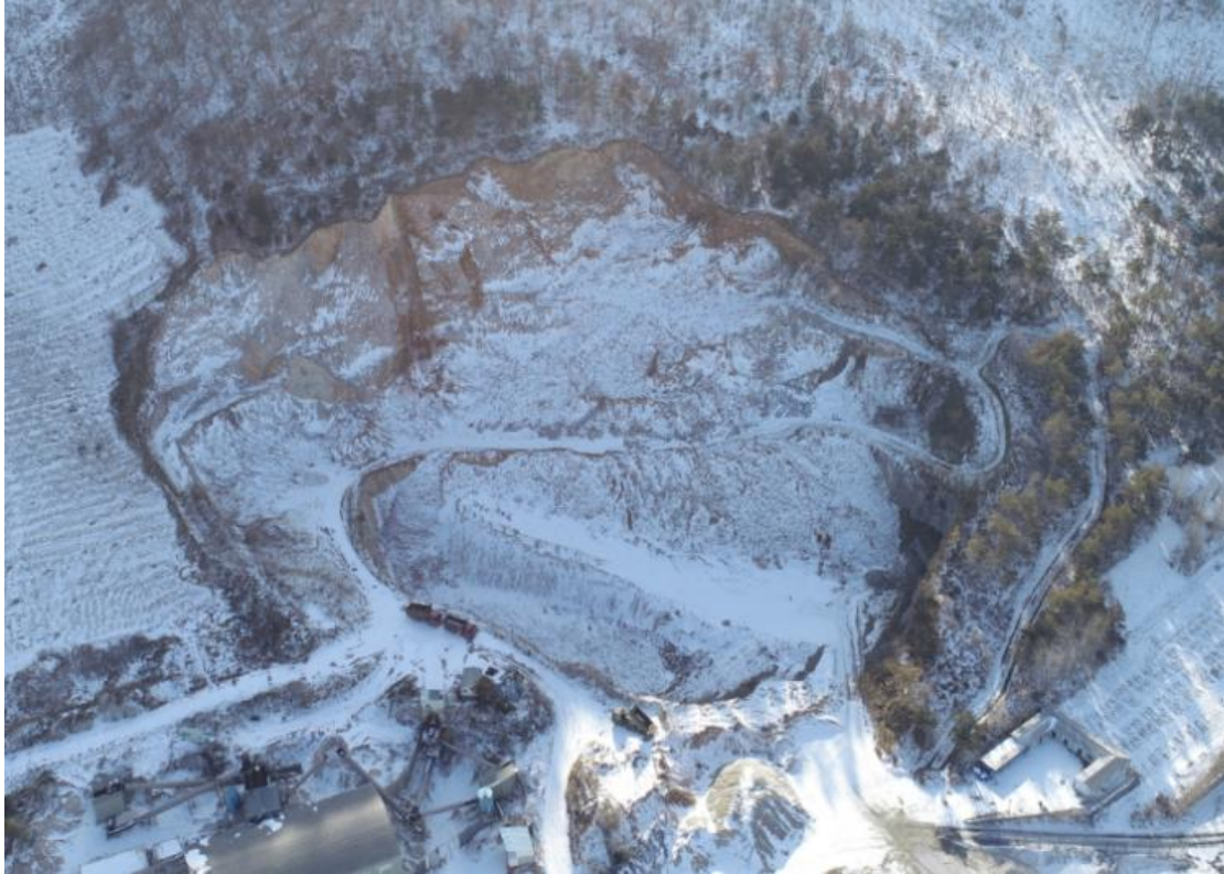
现场照片 3-1 露天采场（拍摄日期 2024 年 2 月 27 日，小河子村境内）
