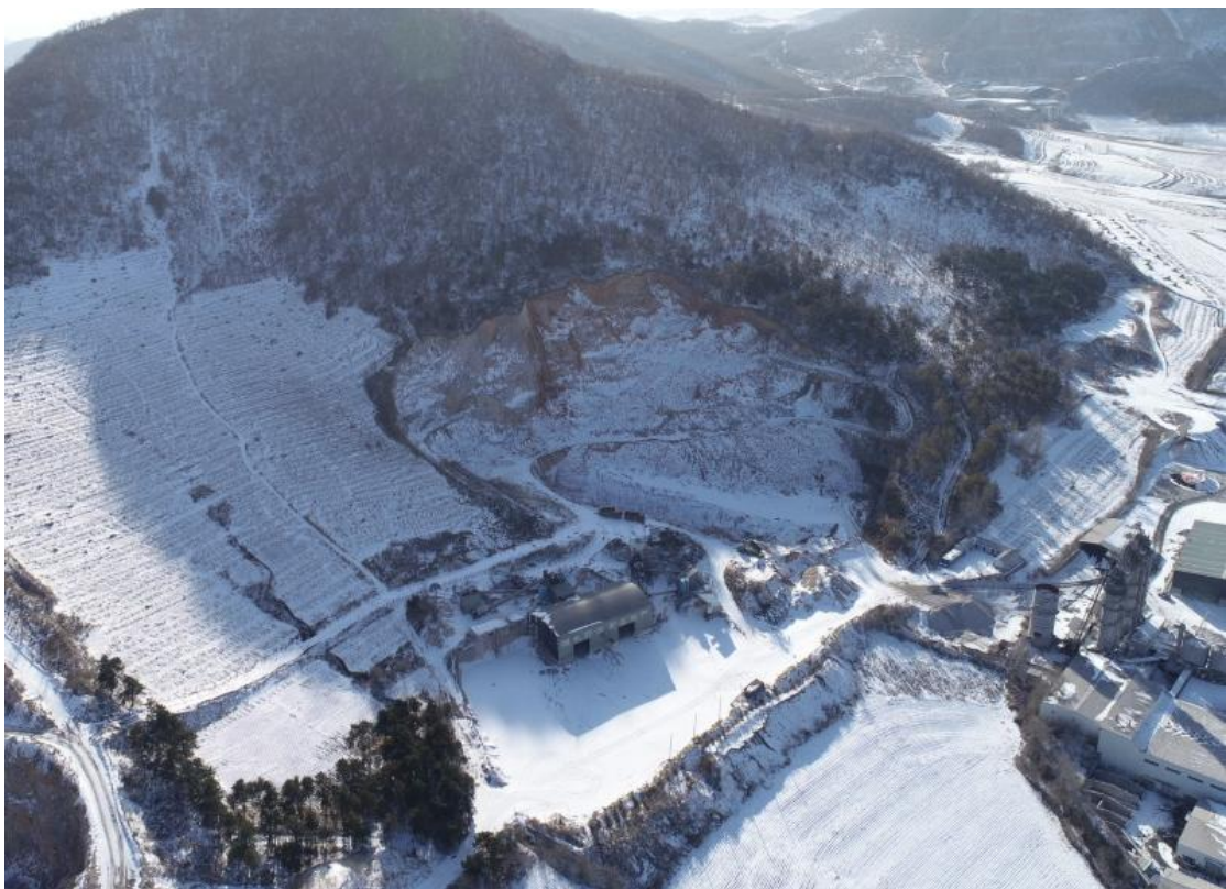
现场照片 1-3 露天采场和工业广场（拍摄日期 2024 年 2 月 27 日，小河子村境内）
